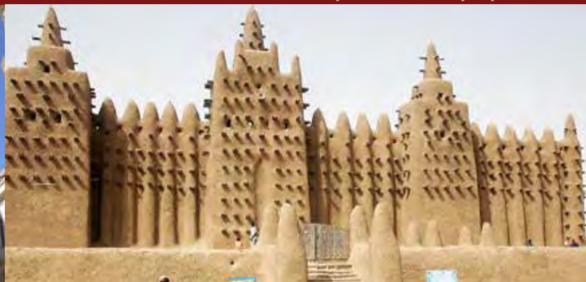
Djennén suurmoseija on maailman suurin savitiilirakennus. Vaikkei se ehkä kuulostakaan kovin vaikuttavalta, on moskeija valtava ja elegantti sekä kaukaa että läheltä. Kaksi kertaa vuodessa kaupungin asukkaat jättävät muut tehtävänsä, kantavat savea läheisestä Bani-joesta ja kunnostavat yhdessä moskeijan muurit.
